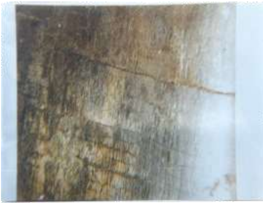
Thermal Crack
